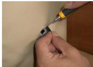
写真のように、カッター等でARの台座部分が見えるように、切り込みを入れて下さい。
